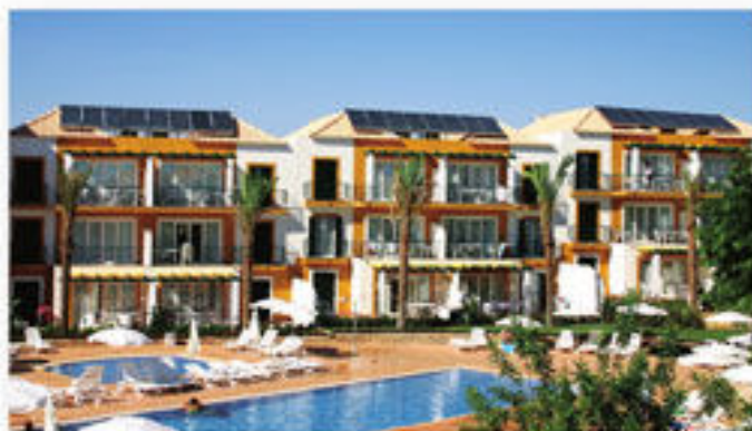
Aquecimento de 13 500 litros/dia de água sanitária num aparthotel em Tavira
